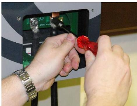
Esempio mostrato: collegamento del cavo di tratta attraverso l'apertura sul lato destro. Usare una coppia di 9-10 Nm per i bulloni in acciaio inossidabile M8. Fusibili dietro la copertura sinistra.
