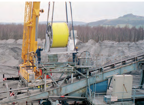
Gli esperti di Conductix-Wampfler assistono i clienti dalla pianificazione al pre-montaggio fino all'installazione in loco in tutto il mondo.
