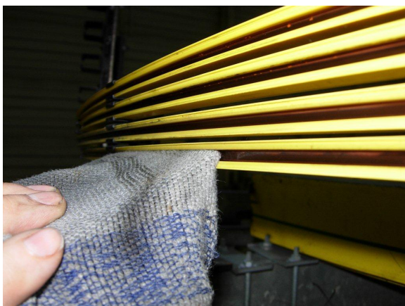
Illustrazione 10: Modificare l'angolo di incidenza dell'attrezzo per la pulizia per pulire le diverse zone
