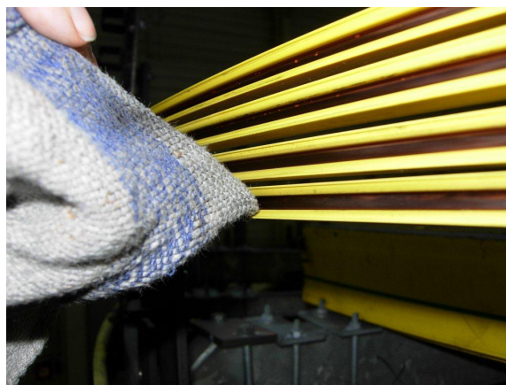
Illustrazione 11: Angolo di incidenza per pulire le zone inferiori
