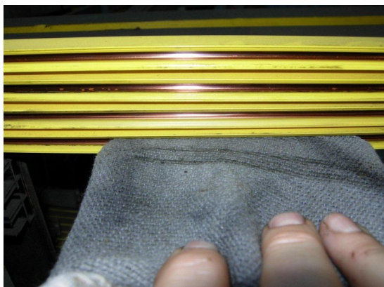
Illustrazione 8: Pulire tutti i poli della fila
